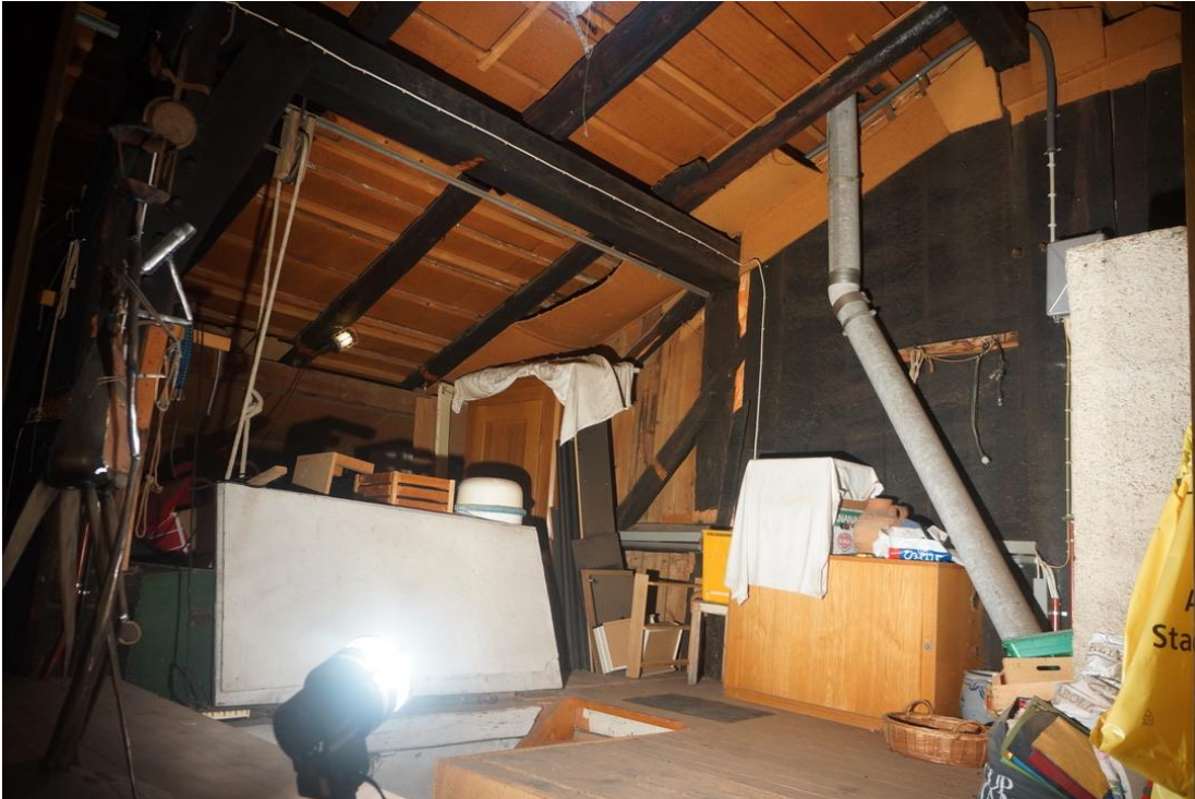
Massig Raumhöhe und Ausbaureserve im Dachstock
