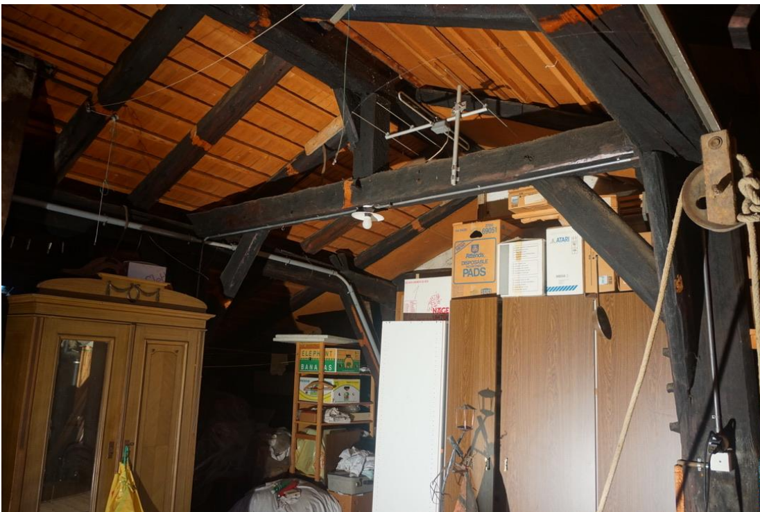
Original Balkenwerk mit ursprünglichen Holznägeln in Top Zustand
