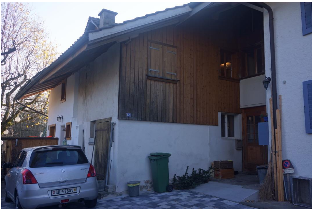
Nord/West-Fassade mit Autostellplatz
